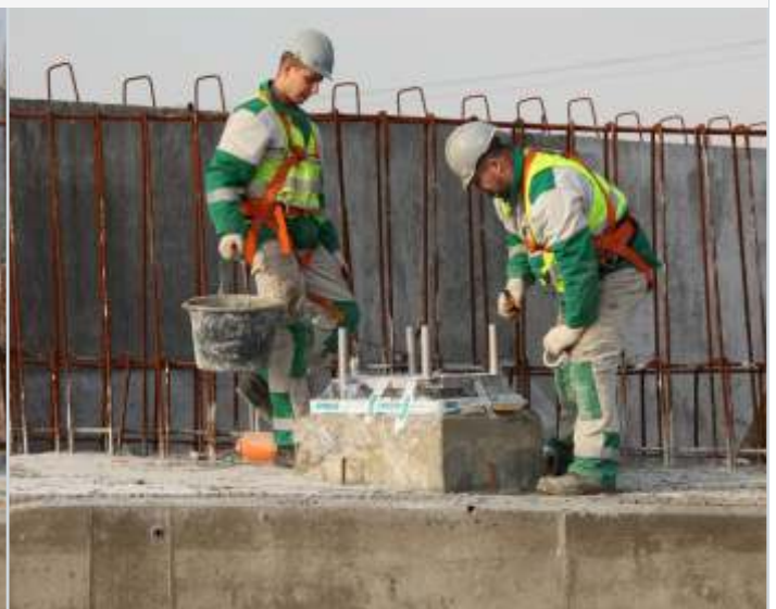
6. Защита опорного элемента
