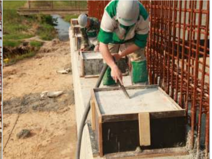
4. Установка и нивелировка эластомерного опорного элемента
